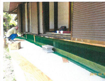
防獣ネットを取り付けました。
